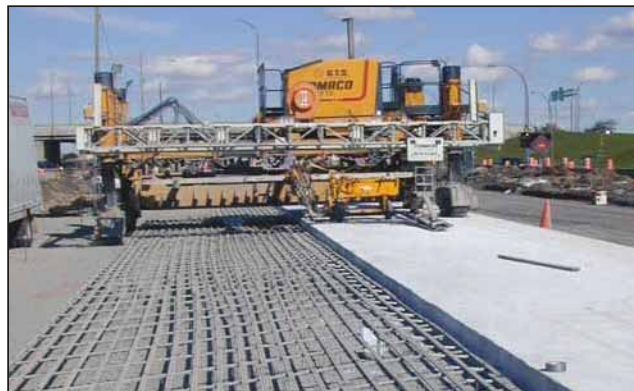
高速公路安全监测
